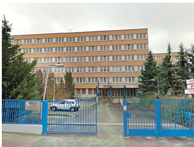
1. ábra. Az épület homlokzata
