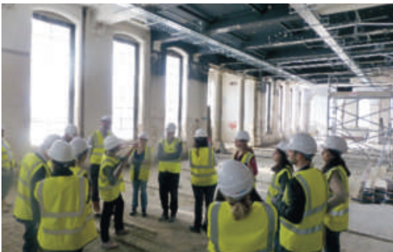
Slika 4 Strokovno voden ogled gradbišča prenove stavbe
